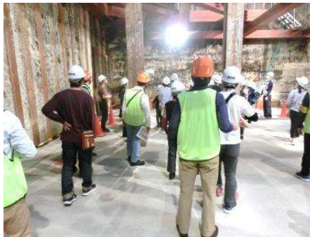
5. 工事用階段で地下2Fに降りてい ただき、現在使用している梅田駅の 壁を外側から見ていただきました。
