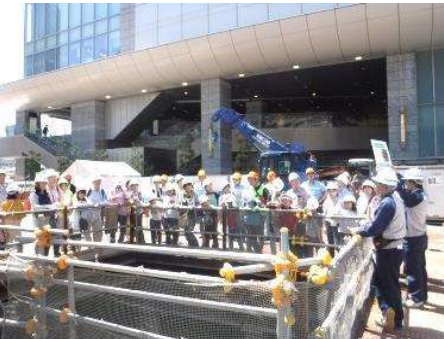
7. 開口部より掘削完了の状態を見 ていただきました。
