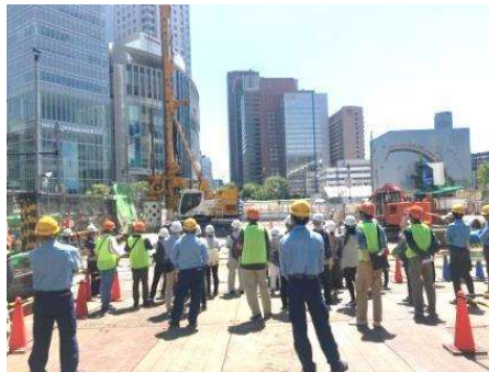
8. 使用している機械の大きさや重さ などの説明を受け、実際に機械で障 害物を壊し、つかんで、機械から取り 出される状況を見ていただきました。
