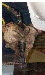
(a)ピーニングツール（フラックスチップ）と疲労き裂を閉じるICR処理
