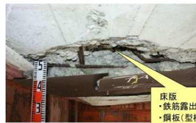
③床版の著しい剥離損傷
