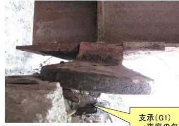
①沓座の崩壊による沓の脱落
