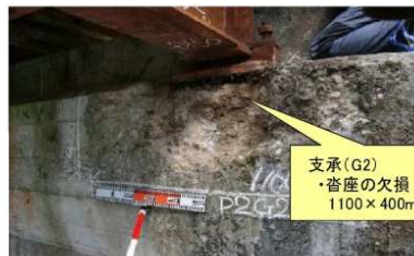
②沓座の崩壊による沓の脱落
