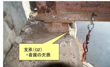
②沓座の崩壊による沓の脱落
