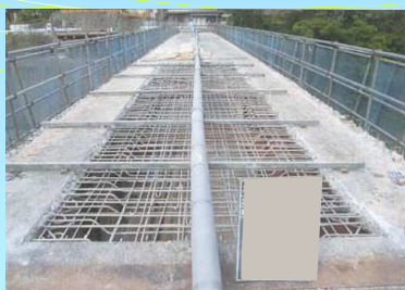
床版欠損部撤去
