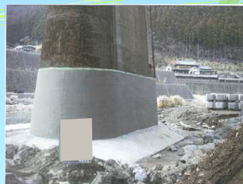
下部工補修完了
