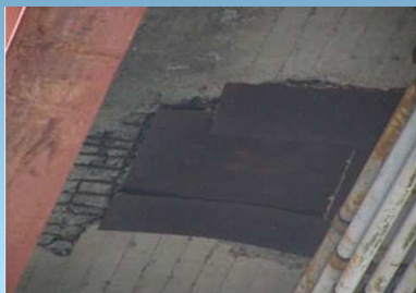
床版欠損部撤去
