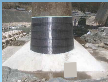
下部工補修完了
