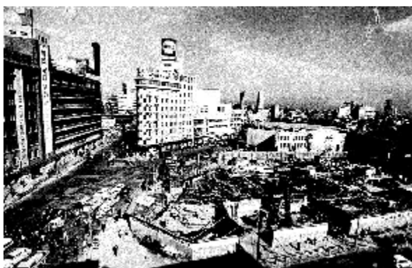
(写真提供 大阪地下街株式会社)
