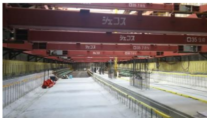
鉄道の工事現場ものぞいてみよう
