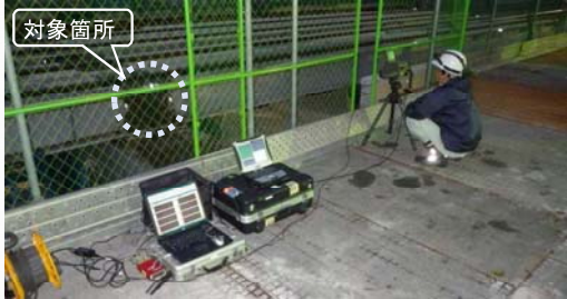
赤外線サーモグラフィーによる撮影状況
