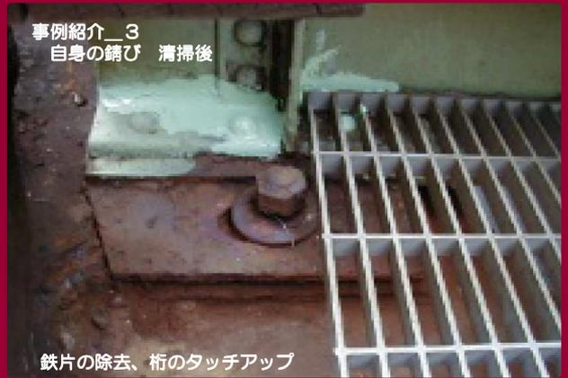
鉄片の除去、桁のタッチアップ
