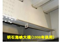
横リブ軸方向に設けられた足場用金具は面外ガセットに相当 → 疲労強度等級F等級
