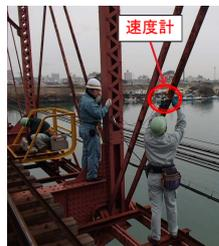
**実測振動数 > 標準振動数 ⇒ 過緊張状態**
