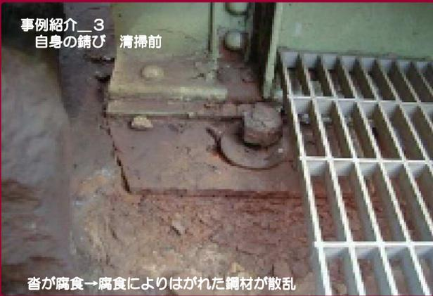
沓が腐食→腐食によりはがれた鋼材が散乱
