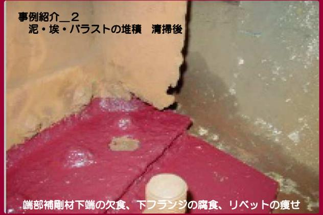
端部補剛材下端の欠食、下フランジの腐食、リベットの痩せ
