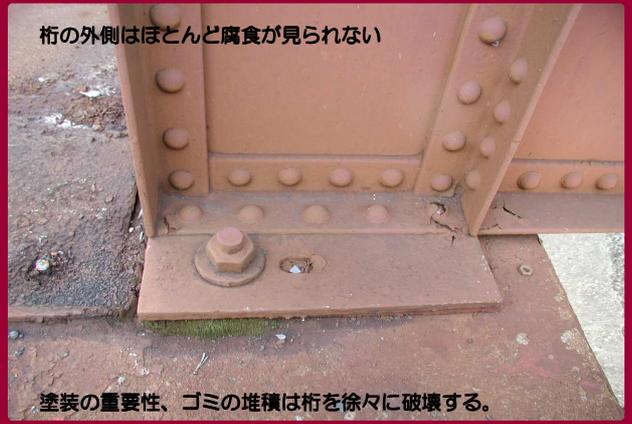
塗装の重要性、ゴミの堆積は桁を徐々に破壊する。
