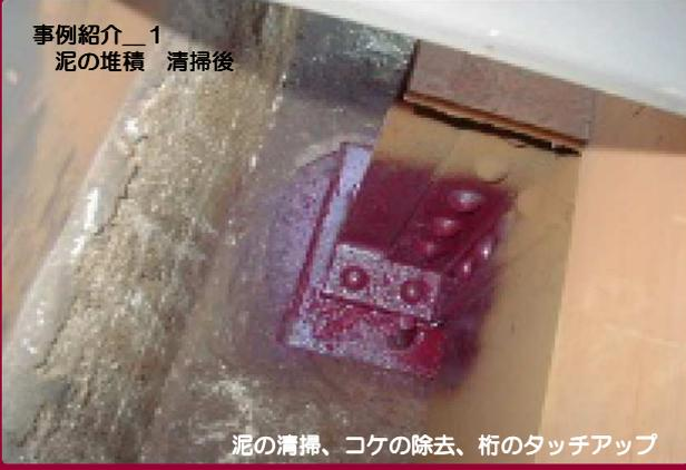
泥の清掃、コケの除去、桁のタッチアップ
