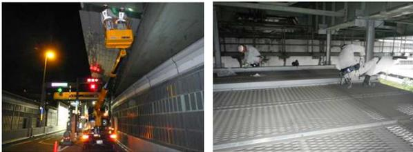
【高所作業車での接近点検状況】
