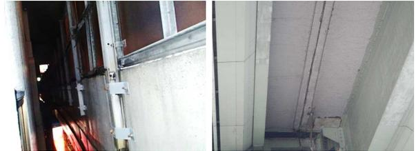
本線の上・下線の併走近接、本線と出入路の近接、建物と道路構造物の近接等。これまで打音や衝撃確認による点検が行えていない箇所
