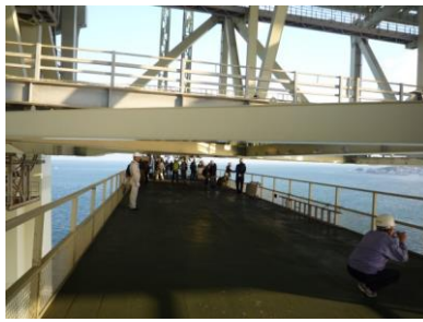
▼この作業車を使って、明石海峡大橋の点検や塗装、補修などが行われるそうです。
