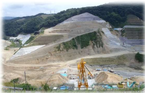
安威川ダム(建設中)
