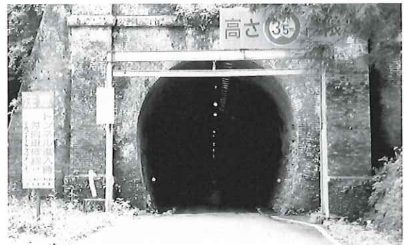
■山中トンネル
