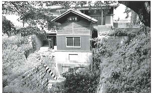
■龍ヶ池揚水機場
