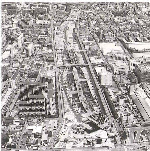
■正蓮寺川の陸地化が完了し開削トンネルを施工している状況
